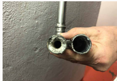
Moderne Rohrrinnensanierung, Vorher und Nachher
