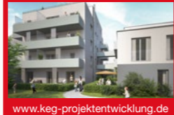
90443 · Dammstr. · ETW, PH
