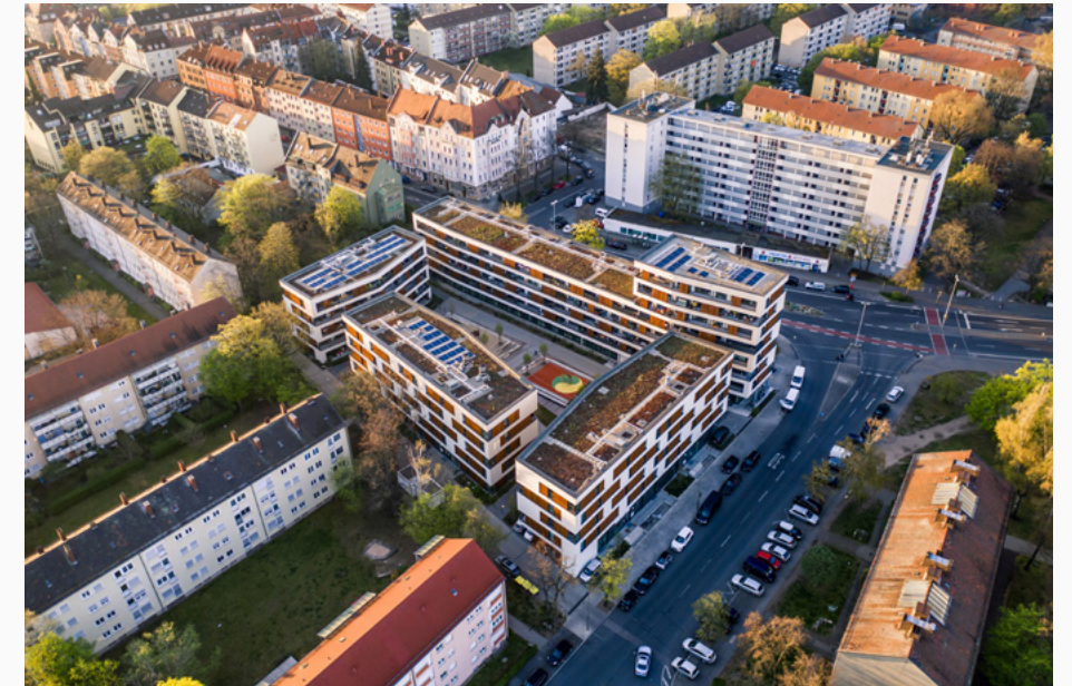
Kombination von extensiver Dachbegrünung und Photovoltaikanlagen auf dem Neubau Rothenburger Straße/Berthavon-Suttner-Straße. Foto: Jacco Kliesch
