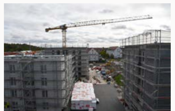
Blick über die Baustelle Colmberger Straße.
