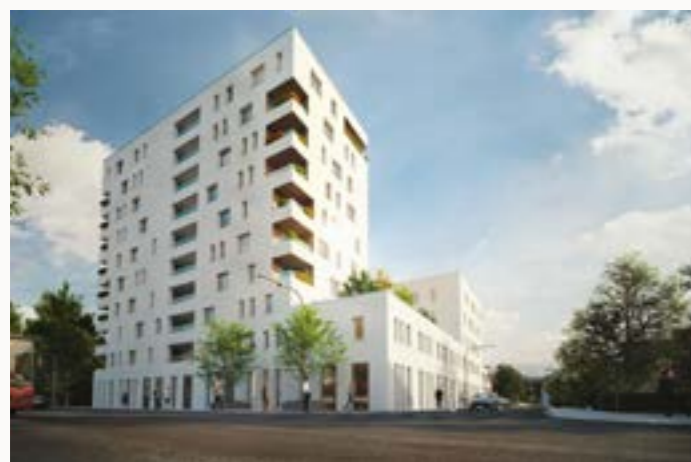
Neubau eines Wohn- und Geschäftshauses in der Gebbertstraße in Erlangen (2. Bauabschnitt). Das Investitionsvolumen liegt im zweistelligen Millionenbereich.
